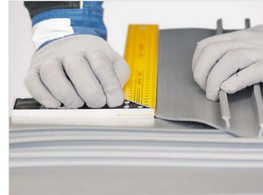
– Обеспечьте ровность стыковки двух элементов при помощи измерительного инструмента.
