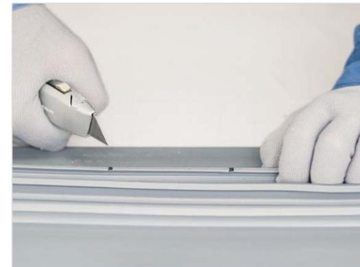
– Удалите часть ребра второй заготовки, которая мешает стыковке.
