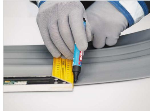
– Разметьте заготовку для последующей обрезки ее краев под углом **45°**.
